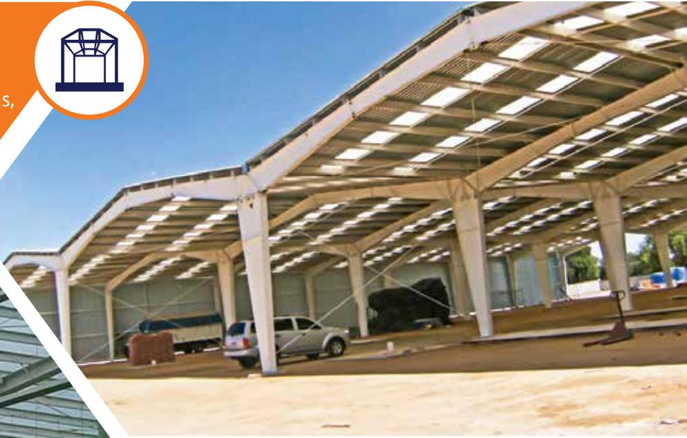
Sus elementos pueden ser de sección recta ó variable, logrando cubrir claros de hasta 90 m, permitiendo así interiores libres o espacios universales. El sistema de Marco Rígido permite pendientes de cubierta menores y son de rápida construcción lo que induce en un menor costo.
