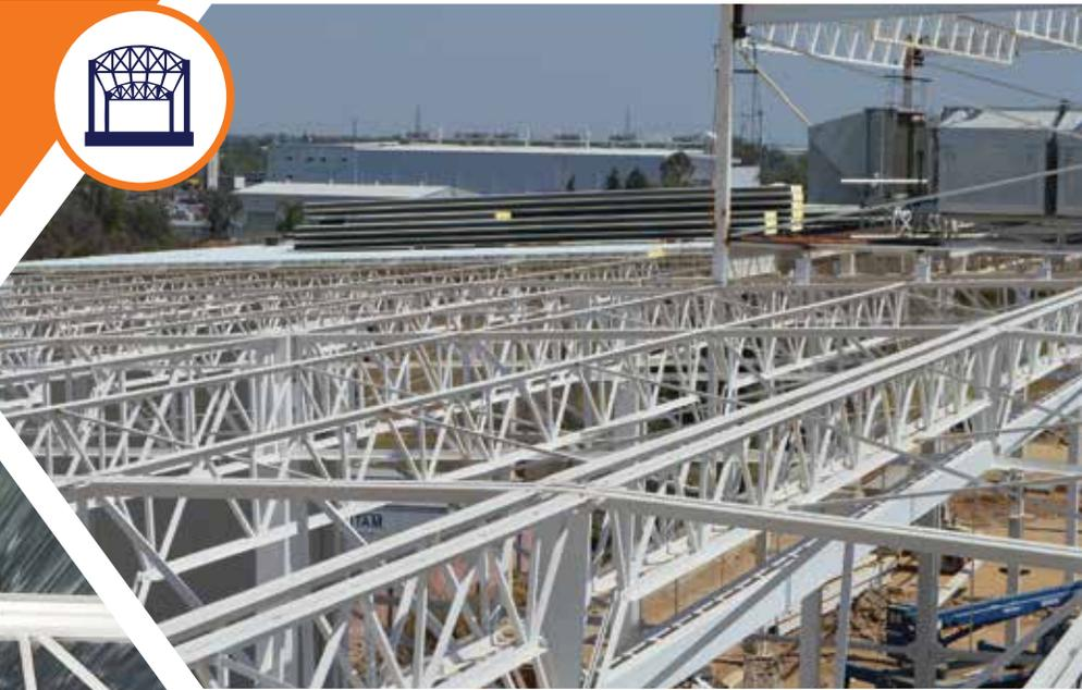
Son de fácil construcción ya que pueden ser fabricados en piezas soldadas y armarse en campo por medio de conexiones atornilladas.
