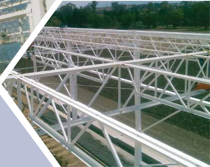
Las conexiones pueden ser soldadas o atornilladas lo cual permite una facilidad en su montaje.
